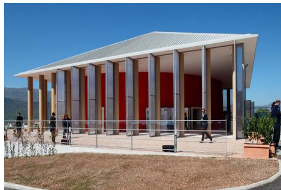
La sala concerti di Shigeru Ban a L'Aquila – Acciaio, cartone, sacchi di argilla.
